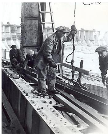
Рис. 2. Клепанные конструкции (1930 г.)
